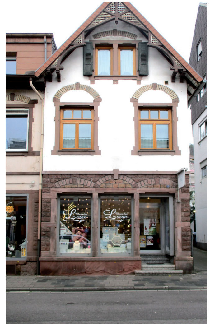
Erhaltene Fassadengliederung trotz Schaufenster und Eingangsbereich im EG
