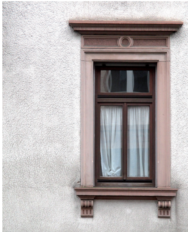
Braunes Holzfenster mit Oberlicht, gefasst von Sandsteinlaibung mit waagerechter Verdachung
