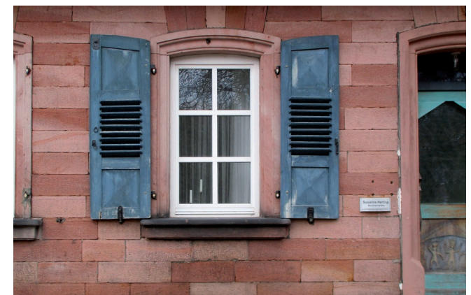
Holzprossenfenster in weiß mit Klappläden
