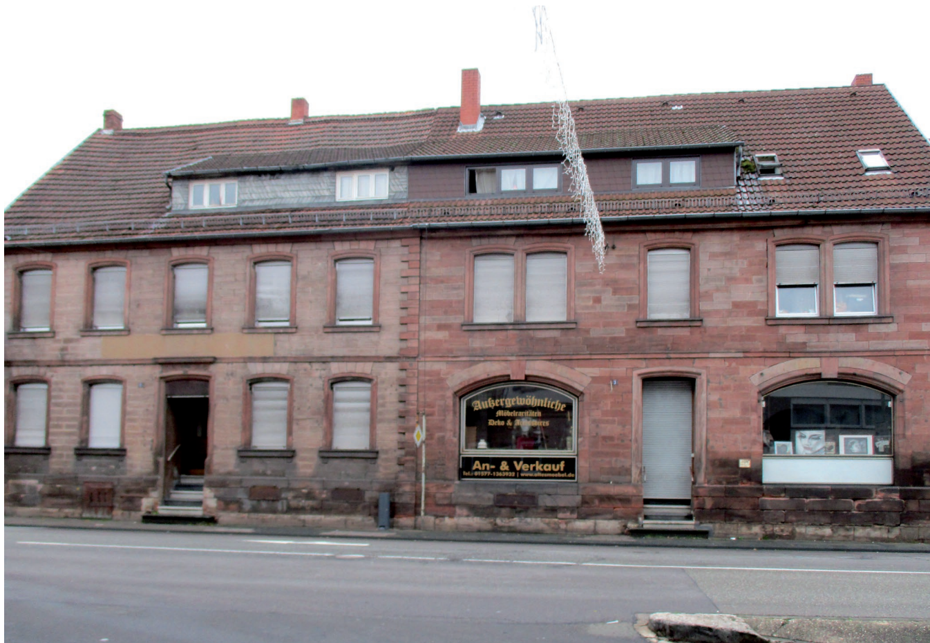
Gründerzeitliche Wohn- und Geschäftshäuser
