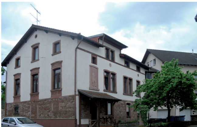
Teilweise erhaltenes Sandsteinmauerwerk und aufgeputzte Fassade
