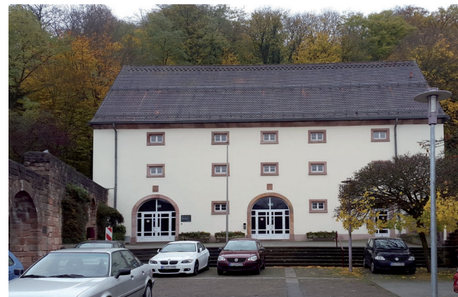
Überputztes Mauerwerk an der Zehntenscheune mit erhaltenen Laibungen
