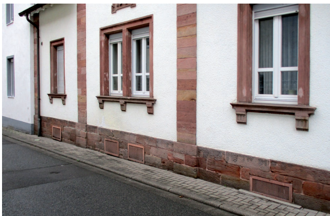
Der Sandsteinsockel und andere strukturierende Fassadenelemente wurden erhalten
