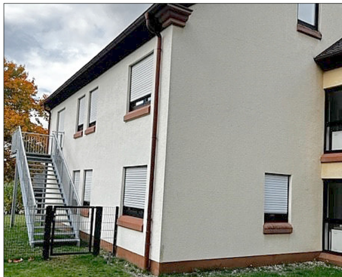
Bild 1: Außenansicht des umgebauten ehemaligen Pfarrhauses:
