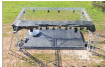
Die Bühne wird gerade aufgebaut.
