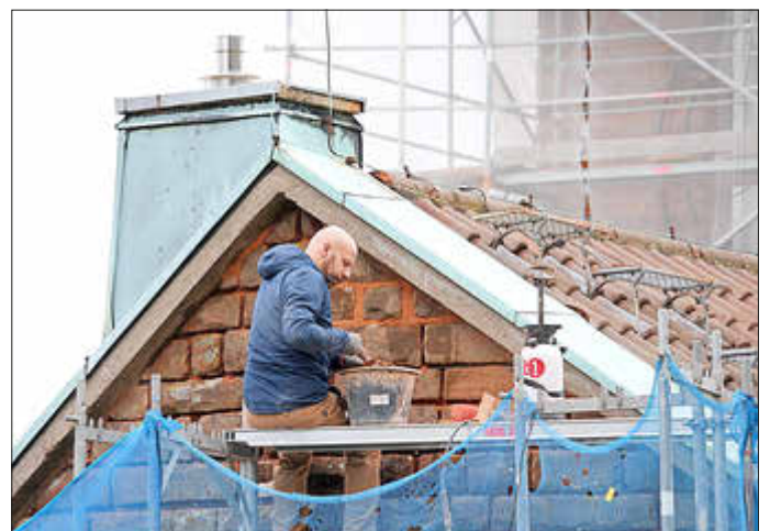
Letzte Sanierungsarbeiten an der Giebelwand/Rückseite - Protestantische Kirche Schopp
